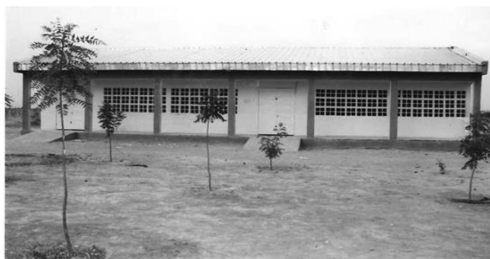
Un bâtiment du CETIC de Salak cofinancé par le PNDP et le Comité de développement de Salak (Cliché : Yadjji Mana le 20/04/2019).
