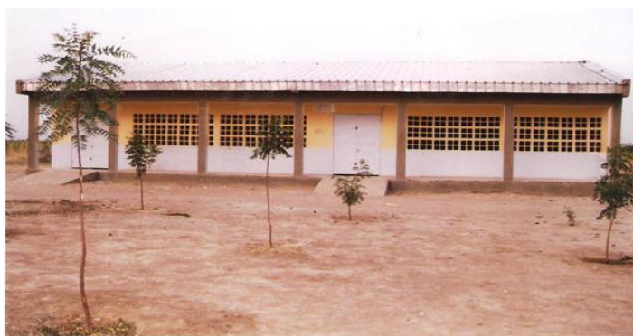
Un bâtiment du CETIC de Salak cofinancé par le PNDP et le Comité de développement de Salak (Cliché : Yadjî Mana le 20/04/2019).
