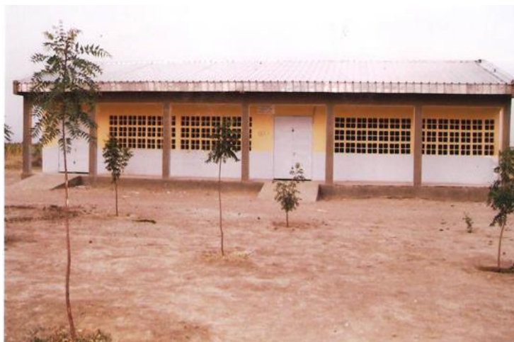
Un bâtiment du CETIC de Salak cofinancé par le PNDP et le Comté de développement de Salak (Cliché : Yadjy Mana le 20/04/2019)
